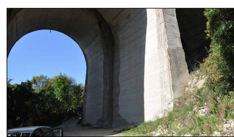
ARCHI Difetto: percolamento con cls. ammalorato e distaccato con tratti di armatura scoperta e fortemente corrosa (VOTO 43) Intervento: Ripristino spigoli archi
